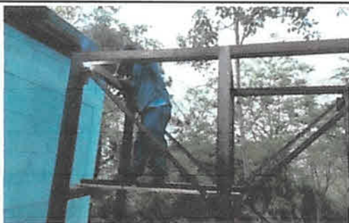
Foto 3: fabricación de pedestal metalico para colocación de tinacos
