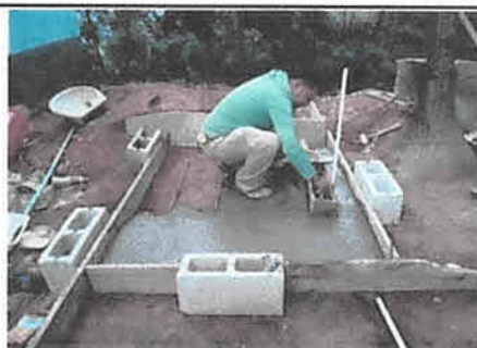
Foto 4: mejoramiento de instalaciones potables y pila nueva.
