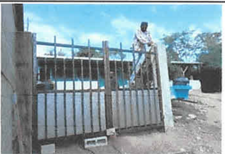
Foto 5: mejoramiento e instalación de porton Principal
