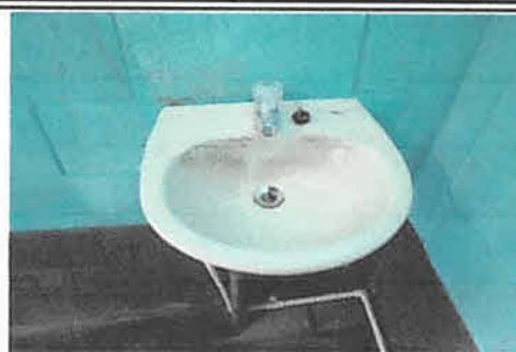
Foto 2: Mejoramiento de instalaciones potables y colocación de lavamanos nuevos
